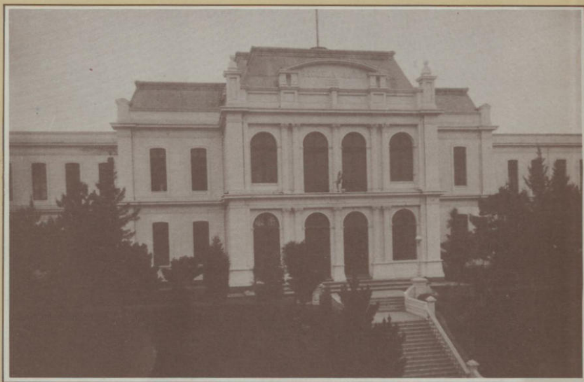
Entrada al edificio antes del terremoto de 1906
