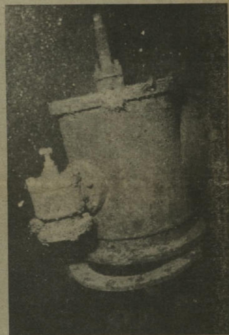
Detalle de la Sala de Máquinas.
