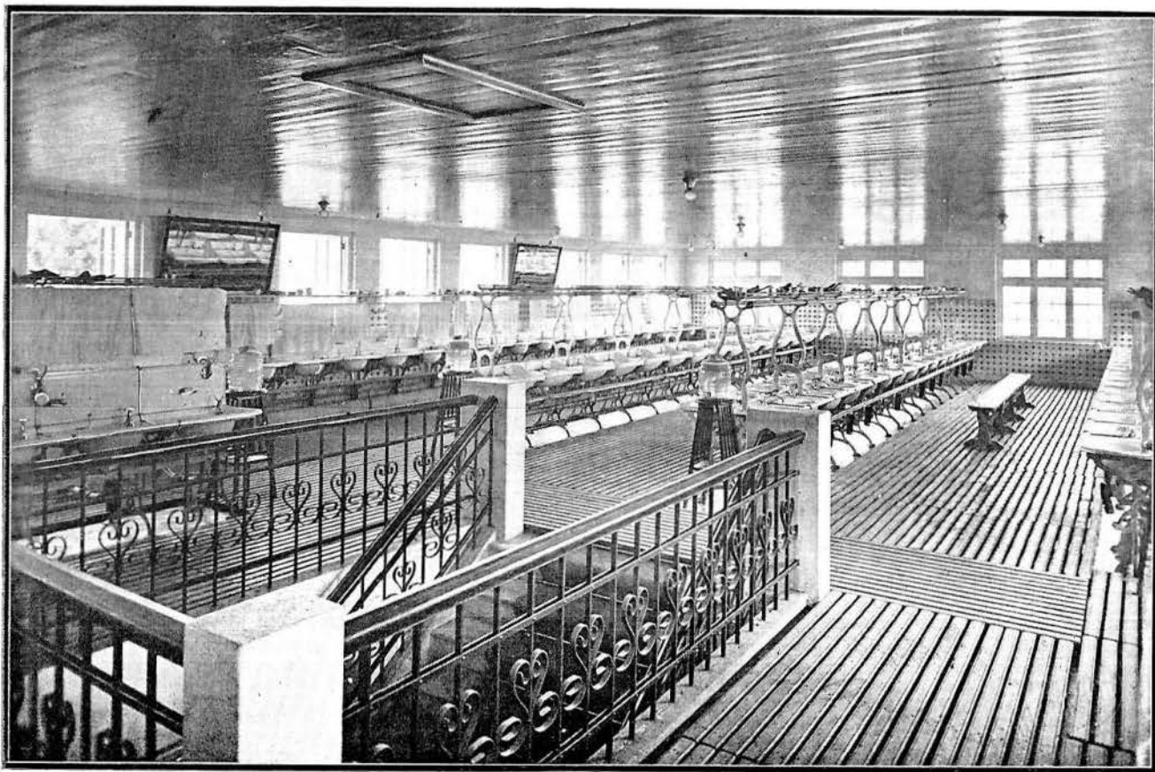
DEPARTAMENTO DE LAVATORIOS.
