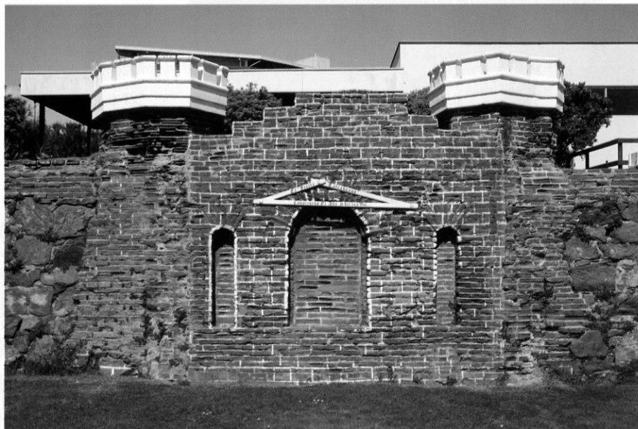
Vista de los restos de las obras de mampostería del Fuerte, en los terrenos de la Gobernación Marítima de Valparaíso.
